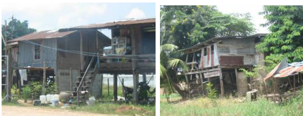
ภาพที่ 1 แสดงสภาพทั่วไปบ้านพักอาศัยของสมาชิกก่อนเริ่มดำเนินโครงการบ้านมั่นคง
